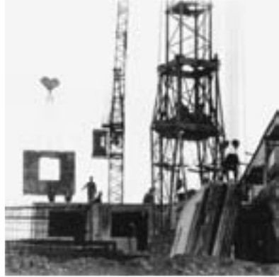
Стройка на БАМе.
