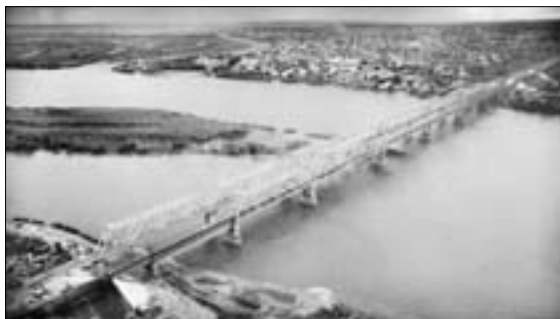
Железнодорожный мост через Обь.
