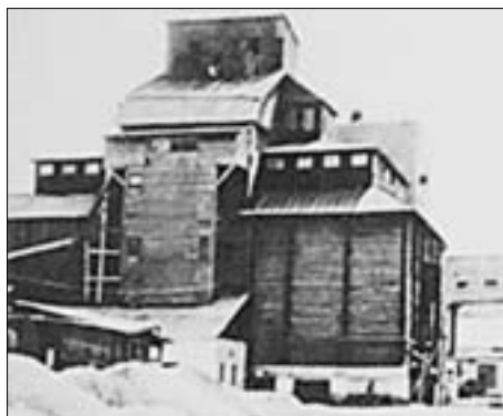
Деревянный элеватор, построенный Юрием Кондратьюком без единого гвоздя.
