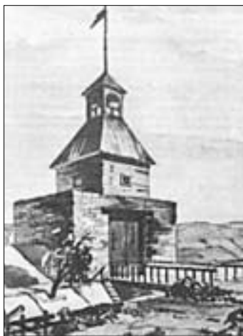
Главная башня крепости Змеиногорского рудника.
