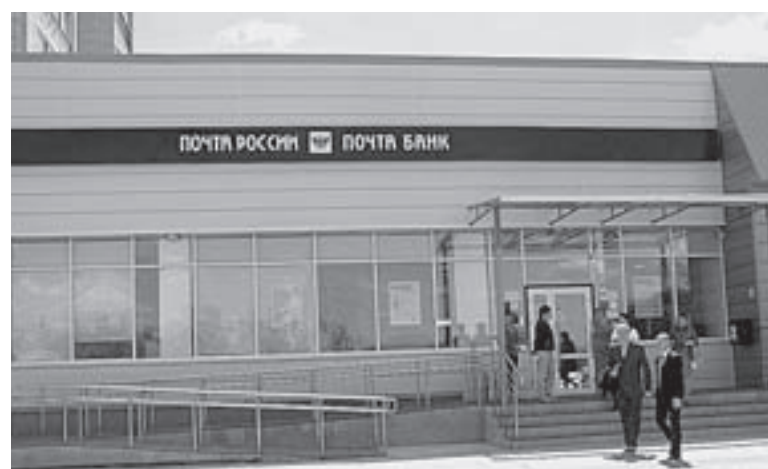
Auch von Außen sieht das renovierte Gebäude modern aus.
