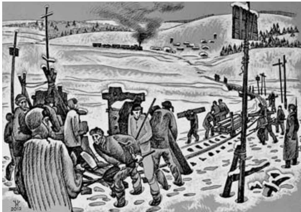
In der Trudarmee. Harte Arbeit am Eisenbahnbau unter Bewachung.
